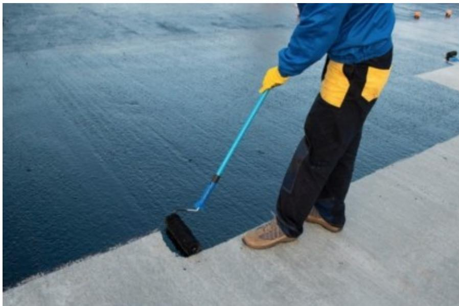
Black Primer è una vernice bituminosa liquida a base solvente con elevate proprietà di ancoraggio, antipolvere e impermeabilizzazione. La vernice è di ottima qualità ed è adatta a isolare coperture strutturali o saturare le porosità del cemento.
